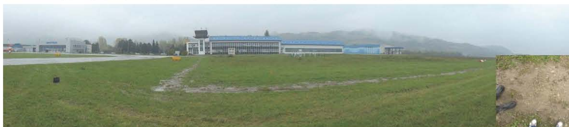
Obr. 1. Pohľady na posudzovanú zemnú konštrukciu z dňa 16. 10. 2012
